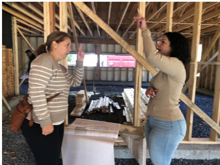
Construction au sein de la Maison d'Athéna
